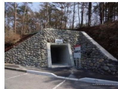
活動火山対策避難施設
